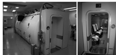
形式: P-1000SE型 (羽生田鉄工) 1993年5月製造 横円筒型直径2.8m 長さ6m 最高圧力 6ATA 収容最高人数 6人「第二種装置」 治療時間 1.5時間、圧力 大気圧+1ATA
