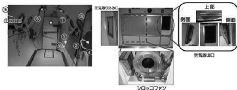
治療室内の測定箇所と空気循環ファン
